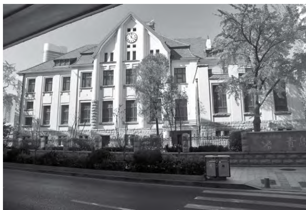
图1 建筑现状 (作者自摄)
