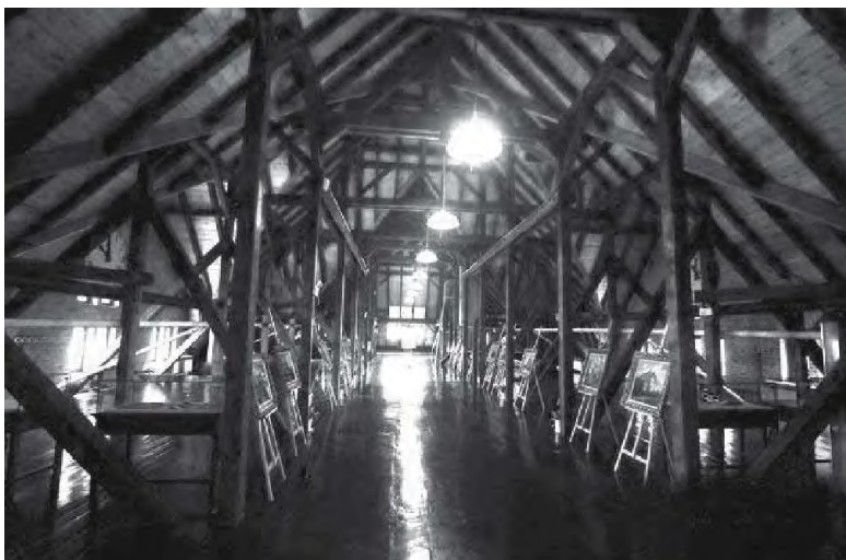
图10 胶海关办公楼双檩条木结构屋顶 (作者自摄)
